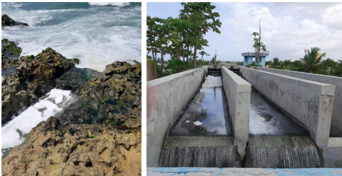
Figura 2. Desagüe del efluente en la planta de Tratamiento en San Pedro de Macorís.
